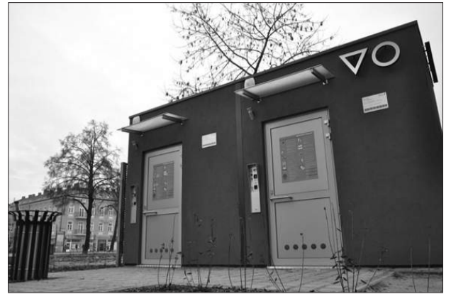
Na placu Daszyńskiego stanęła nowa toaleta publiczna. Powstała na wniosek mieszkańców w ramach budżetu obywatelskiego. Inwestycja kosztowała 245 tys. zł.
