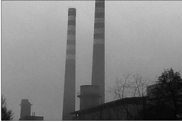
Wraz z poprawą pogody pracownicy krakowskiej firmy Pamar II wznowili prace przy rozbiórce trzech ostatnich, nieużywanych od wielu lat, kominów obok Stalowni ISD Huty Częstochowa.
