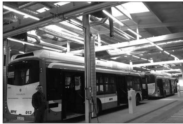
Od niedawna Miejskie Przedsiębiorstwo Komunikacyjne w Częstochowie ma nowoczesną, klimatyzowaną halę do obsługi oraz napraw autobusów z kanałami o regulowanych parametrach.
