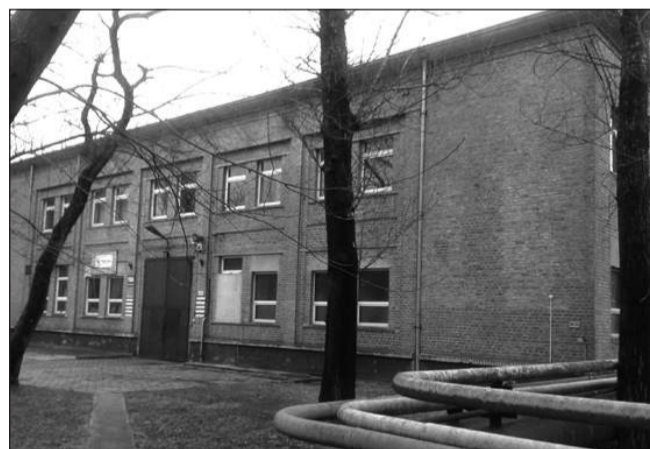
Budynek dawnego Wydziału Budowlanego
