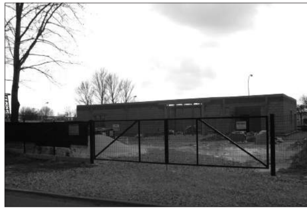
Na działce przy ul. Odlewników 1A zainwestowała firma Dro-Masz, zajmująca się sprzedażą oraz wynajmem maszyn i urządzeń budowlanych. Wznosi tam budynek usługowo-magazynowy.
