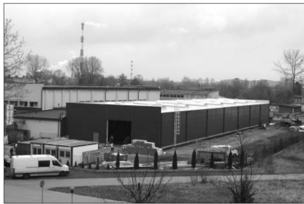
Kolejne inwestycje mają miejsce na terenach pohutniczych. Firma Emo-Neon, produkująca różnorodne elementy reklamy świetlnej, kończy budowę nowej hali przy ul. Kucelińskiej 38/40.
