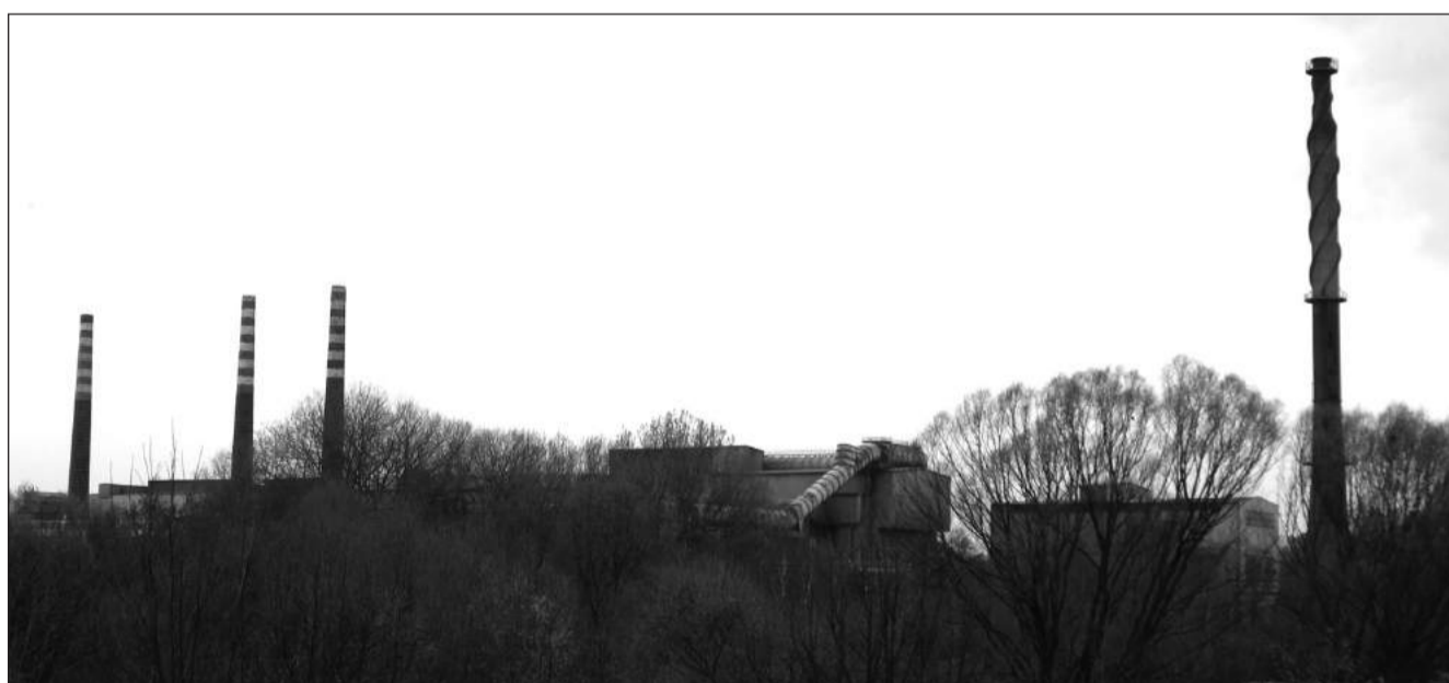
Nieużywany 100-metrowy komin stalowy (z prawej) i trzy 75-metrowe ceglane tuż obok Stalowni wkrótce zostaną rozebrane.
