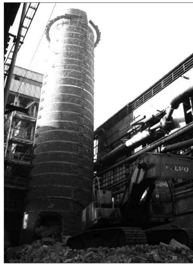
Rozbiórke pierwszego z ceglanych kominów utrudnia jego lokalizacja pomiędzy budynkami Stalowni, w sąsiedztwie wielu instalacji.
