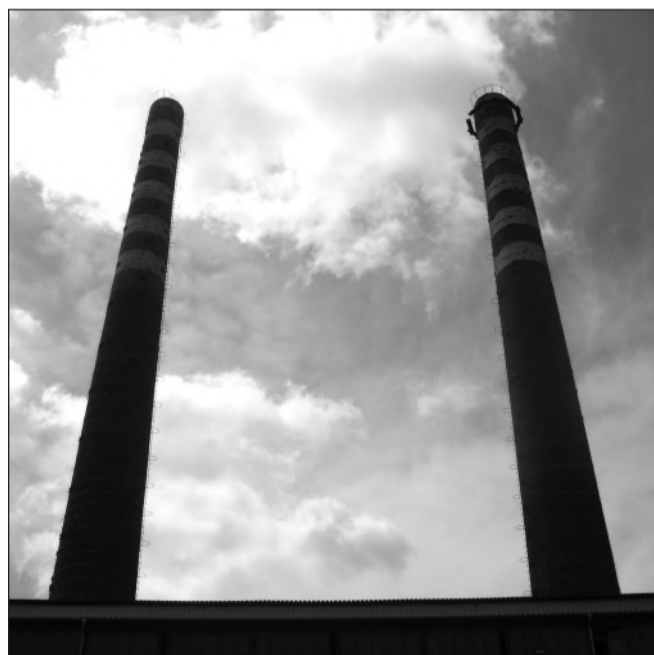
Dwa ostatnie kominy Stalowni. Ten po prawej już w trakcie rozbiórki.
