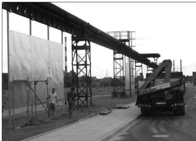
Montaż metalowych tablic, na których artyści namalują obrazy.
