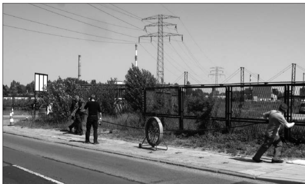
Pracownicy hutniczego Oddziału teleinformatyki własnymi siłami rozciągnęli kabel wzdłuż ul. Korfantego.
