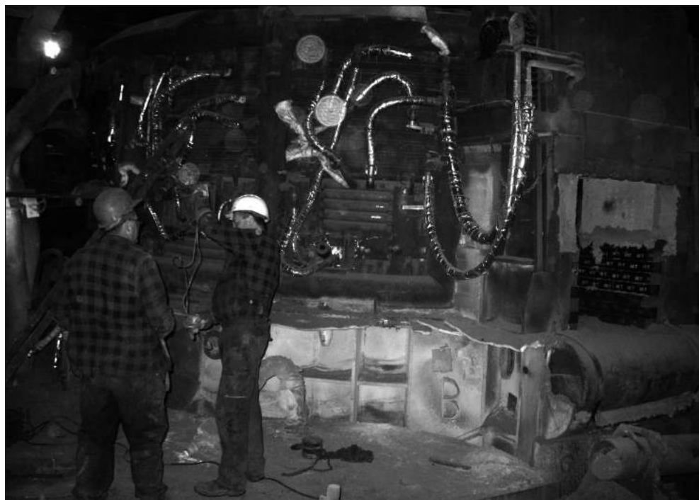
W Stalowni ISD Huty Częstochowa wyremontowany został między innymi piec elektryczny.
