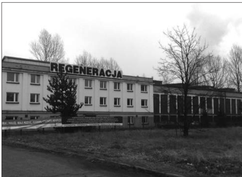
Hala Regeneracji na Rakowie z pomieszczeniami biurowymi należy teraz do firmy Logis.
