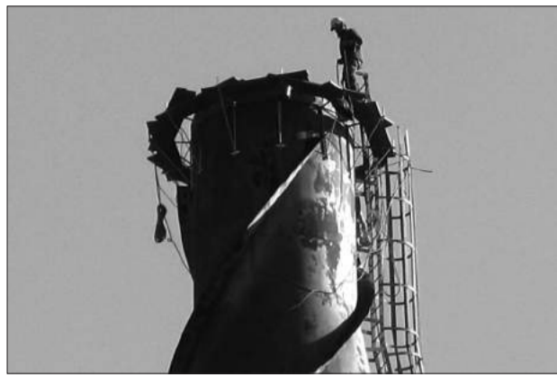
Ekipa z firmy Pamar II, specjalizująca się w pracach na wysokości, od początku tygodnia rozbiera nieużywany, 100-metrowy stalowy komin obok Stalowni ISD Huty Częstochowa. Efekty prac już widać.
