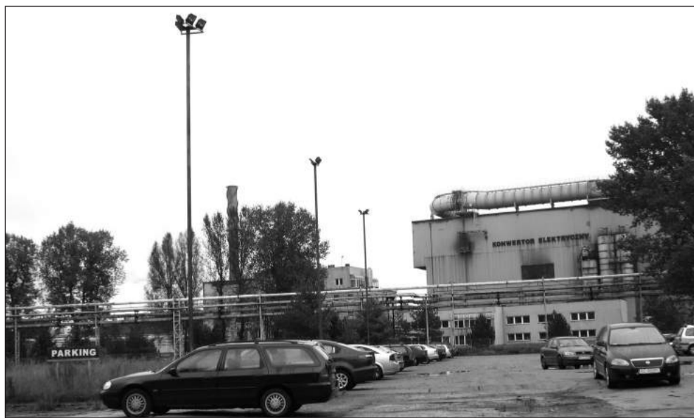
ISD Huta Częstochowa doświetliła już teren parkingu przy Stalowni, a wkrótce zbuduje nowe wejście.
