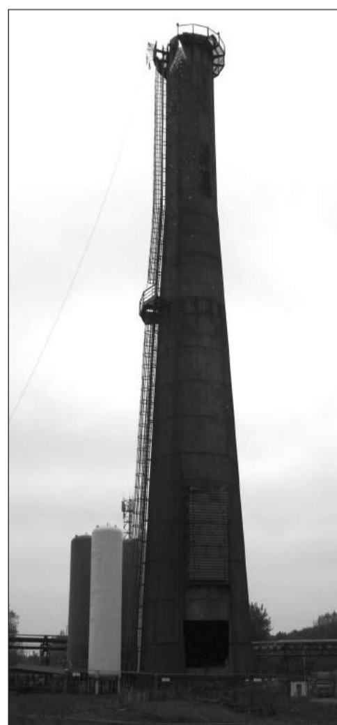
Do rozbiórki pozostało jeszcze 60 metrów kominu.
