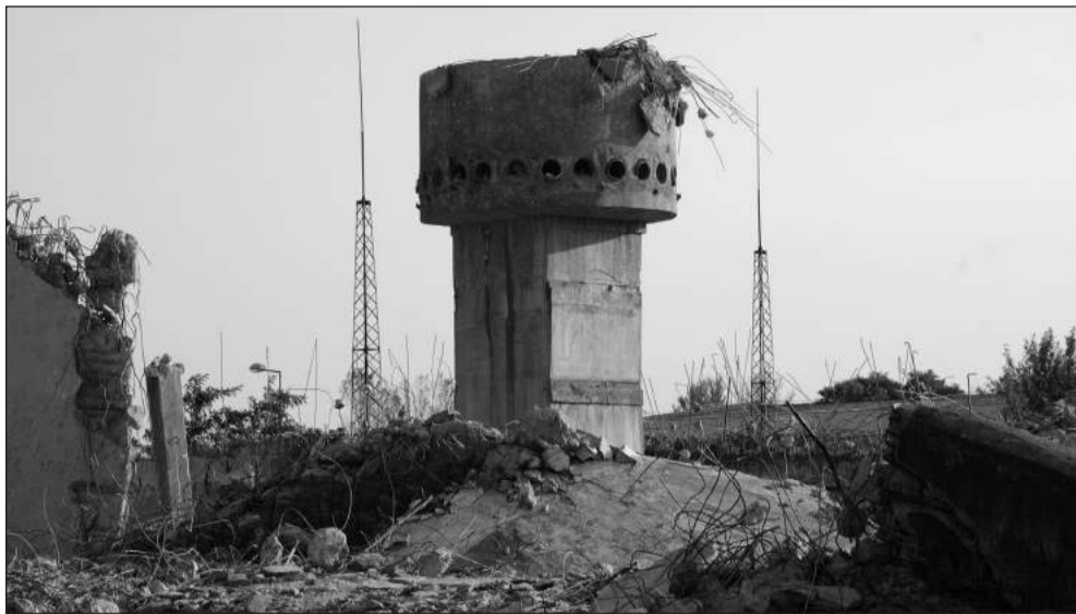
Pozostałości dawnej hutniczej chłodni kominowej przy ul. Wielkopiecowej będą wkrótce uprzątnięte.
