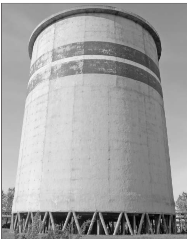
Wyburzona chłodnia miała rzadko spotykany cylindryczny płaszcz.
