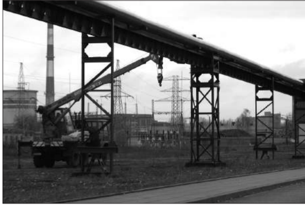
Elsen SA odnawia rurociągi, biegnący wzdłuż nowej drogi przez tereny Specjalnej Strefy Ekonomicznej na Kucelinie. Pomalowano konstrukcję, a obecnie trwa zakładanie nowej izolacji na przewody.
