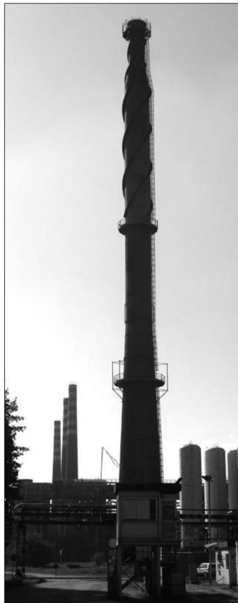
Stalowy komin z charakterystycznym „ślimakiem” tuż po rozpoczęciu rozbiórki we wrześniu.
